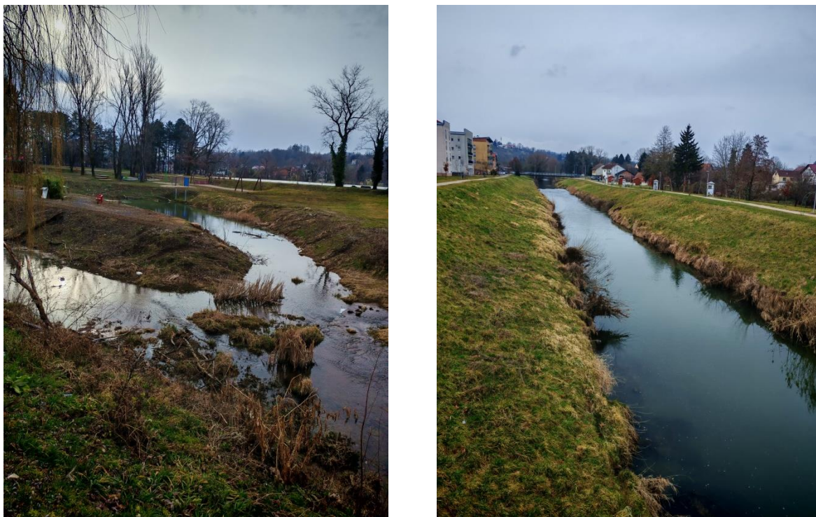
Slika 1: Prikaz postojećeg stanja
