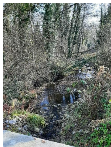
Plitki zamuljeni dio kanala sjeverno uz ribnjake
